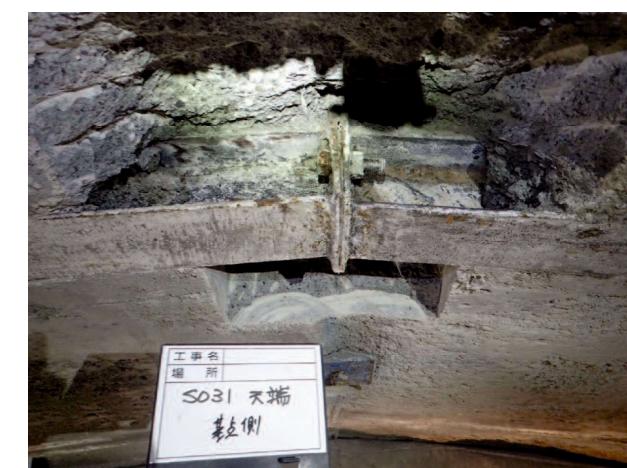
・支保工天端継ぎ手部；変状無
