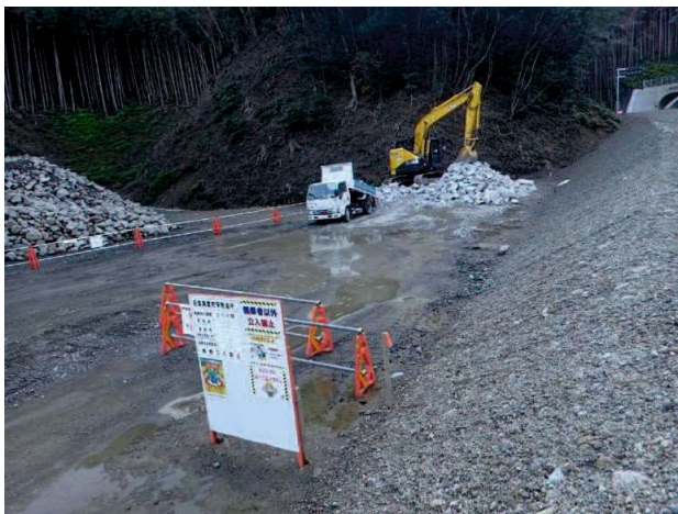
・コンクリート殻仮置き状況
