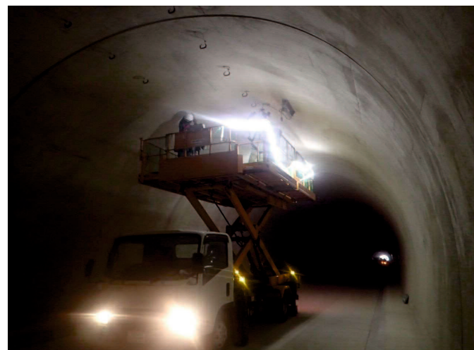
・照明設備撤去状況
