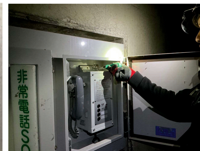
・非常電話撤去状況
