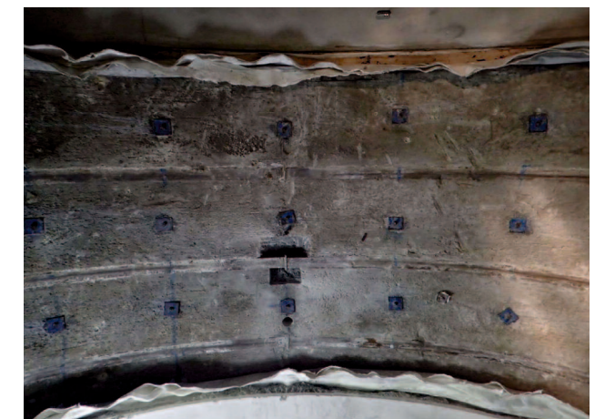
・支保工天端継ぎ手部全景；変状無
