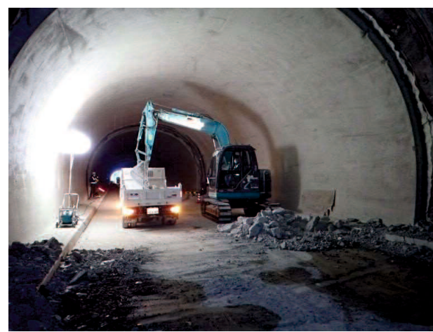
・コンクリート殻積み込み状況
