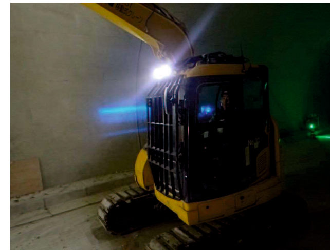
ヘッドガード・フロントガード取付状況
