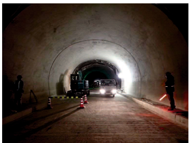
・コンクリート殻運搬状況
