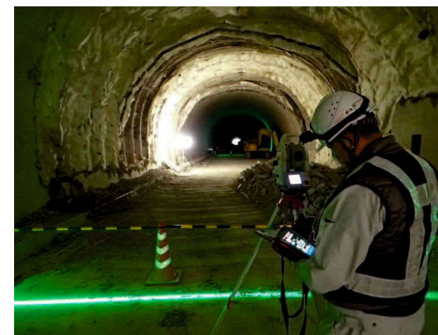
作業開始前の計測工 A
