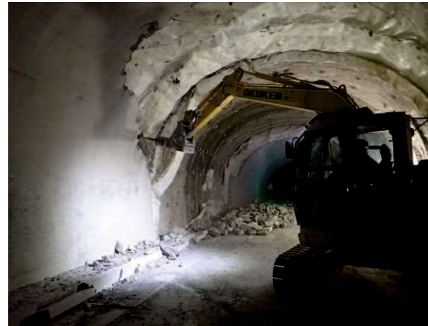
・覆工コンクリート取壊し状況；全景
