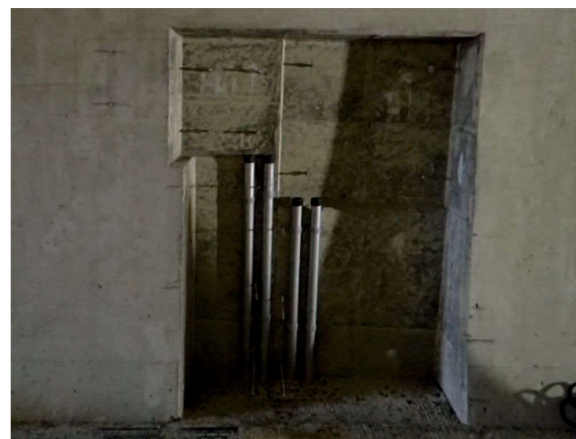
・防災設備撤去後の箱抜き状況
