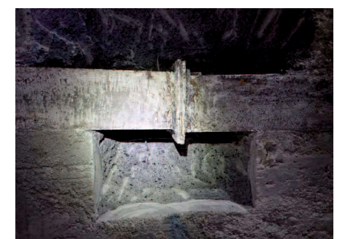
・支保工天端継ぎ手部；変状無
