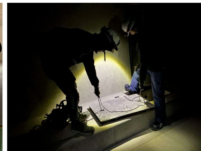
・ハンドホール蓋撤去状況
