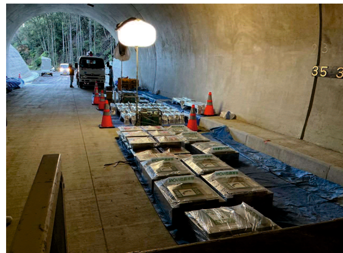
・設備の養生状況（※倉庫に移動して保管）
