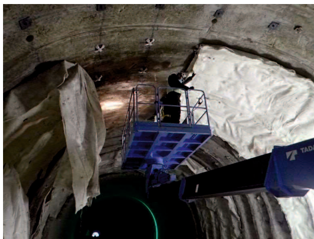
・防水シート撤去状況；近景
