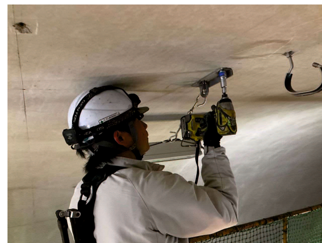
・LED照明撤去状況
