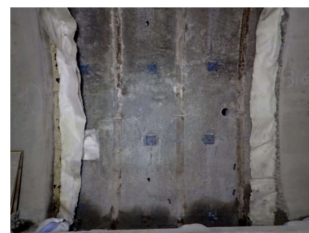
・支保工状況（左側）；変状無
