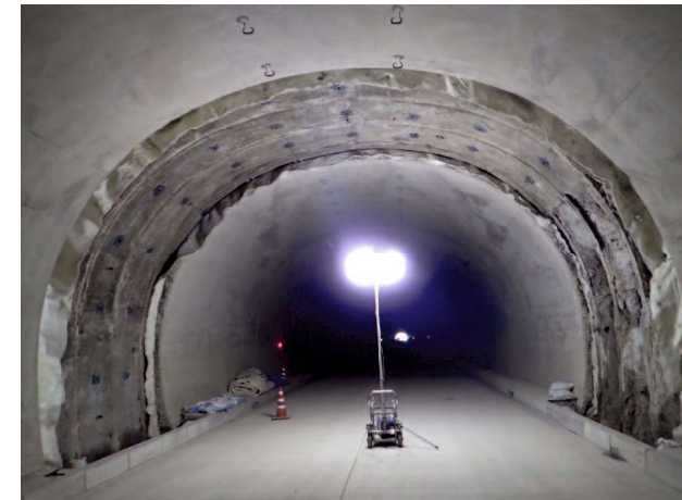
・覆工コンクリート取壊し状況；全景
