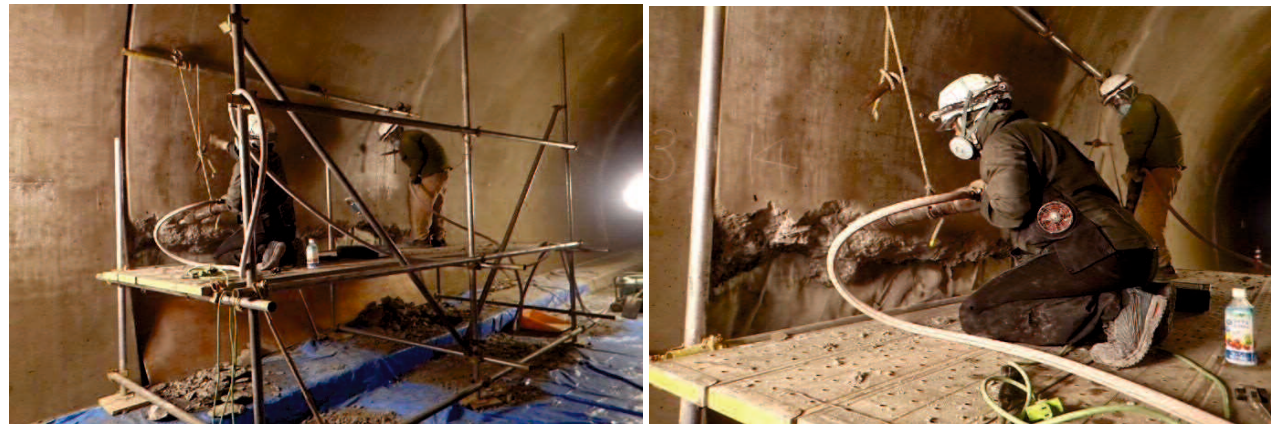
覆工コンクリートのはつり状況
