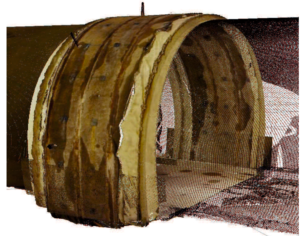
NO.138断面図（施工済み断面の点群データと設計モデルの差分） 点群データ； ———— 設計断面； - - - -
