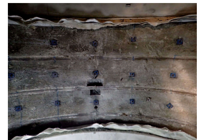
・支保工天端継ぎ手部全景；変状無
