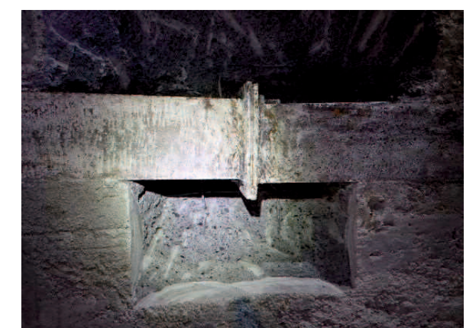
・支保工天端継ぎ手部；変状無
