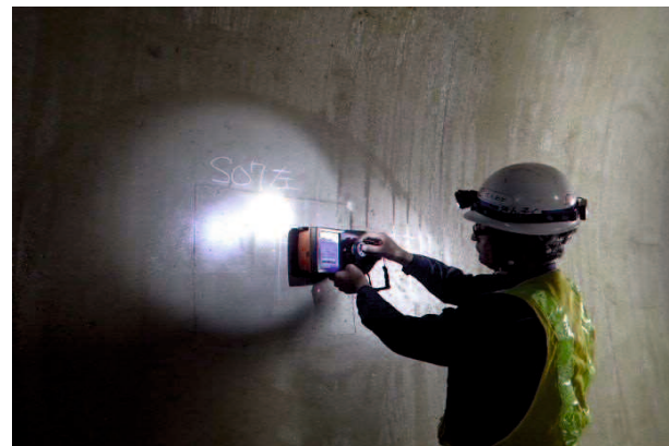
鋼製支保工の位置を、電磁波探査により確認
