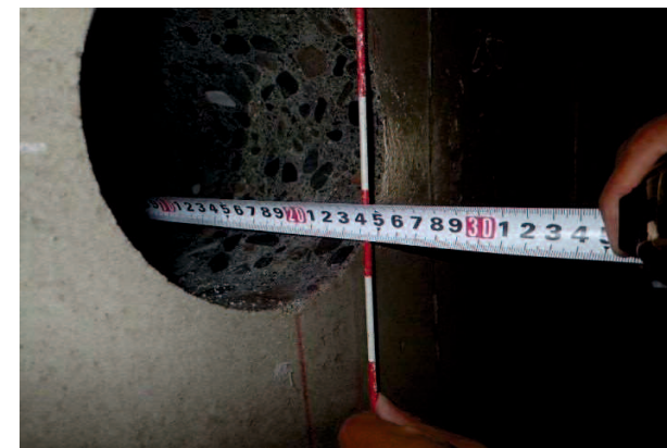
コア孔による覆工厚の確認
