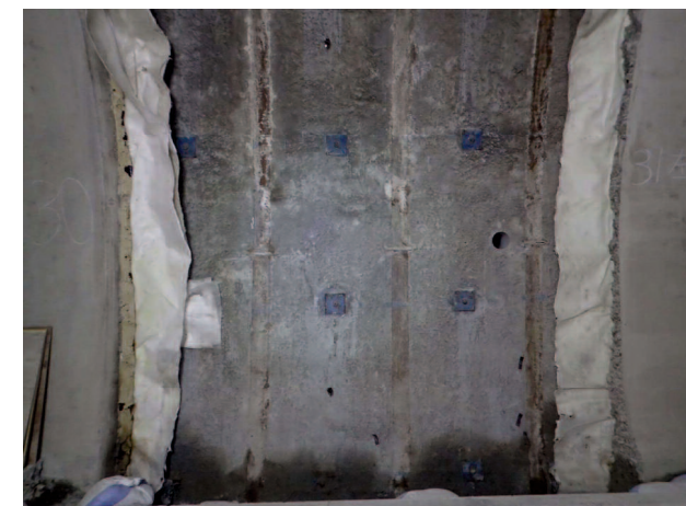
・支保工状況（左側）；変状無
