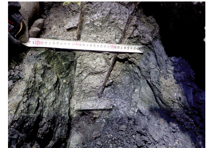
・ インバート内の道路側に鋼製支保工がある。
