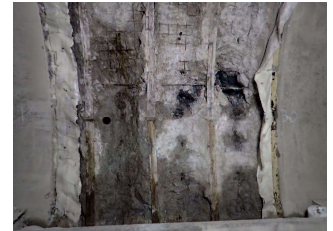
・支保工状況（右側）；変状無
