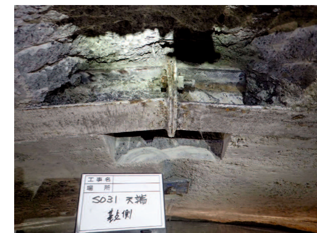
・支保工天端継ぎ手部；変状無
