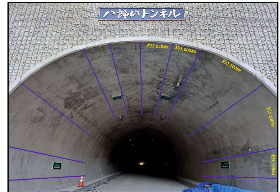
図4.2 地中レーダ探査測線概要写真
