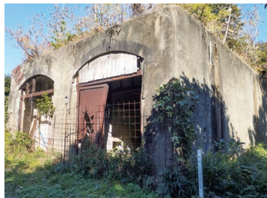
燃料倉庫外観
