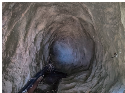
トンネル内部
