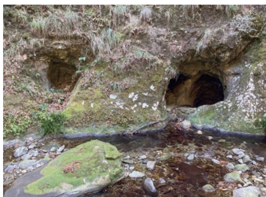
トンネル入口（右坑、左坑は試掘坑）
