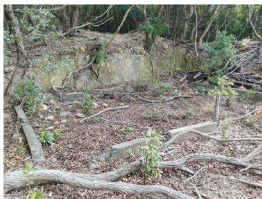
建物コンクリート基礎
