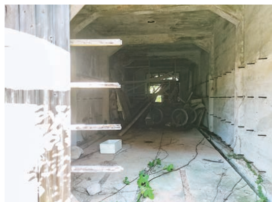
燃料倉庫内部
