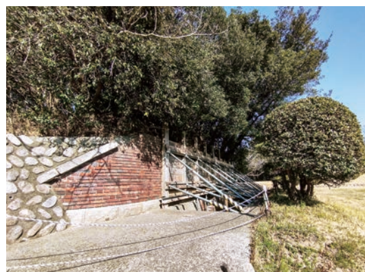
深山第2砲台跡 弾薬庫
