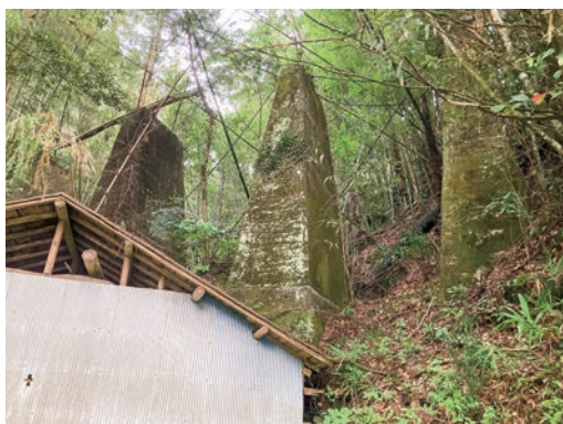
国道 370 号沿いに残る高架橋脚
