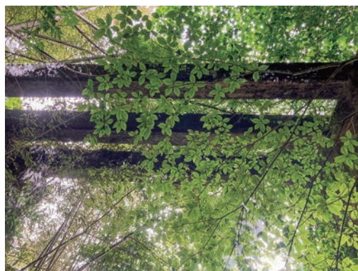
国道 370 号沿いに残る高架橋桁
