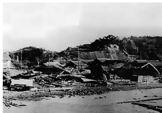
田辺市新庄の紀伊本線紀伊新庄駅付近の被災状況 (和歌山県 1996)
