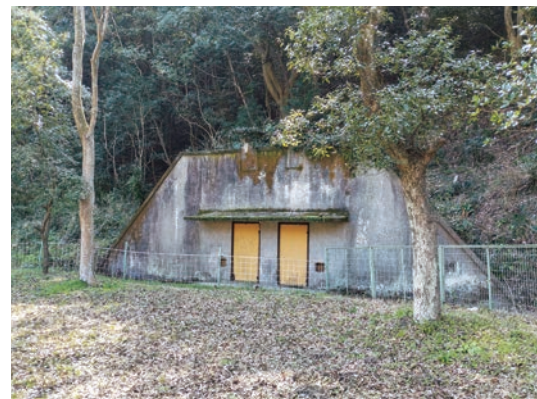
地下壕入口部
