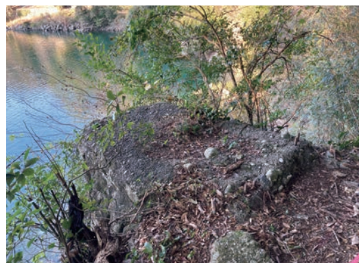
コンクリート構造物
