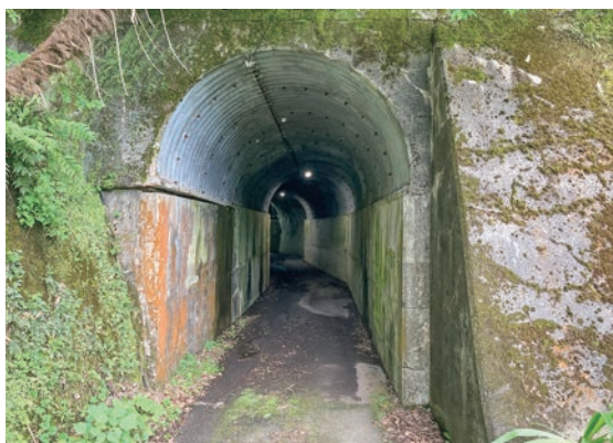
下古沢隧道入口
