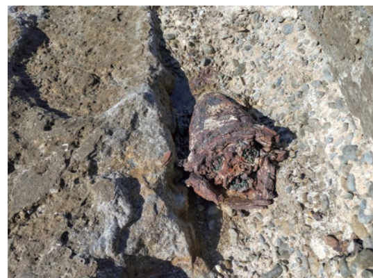
海底ケーブル
