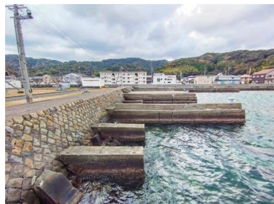
西側護岸の栈橋
