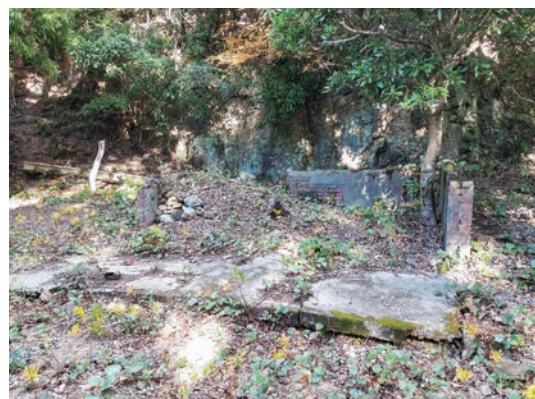
発電所跡・倉庫跡
