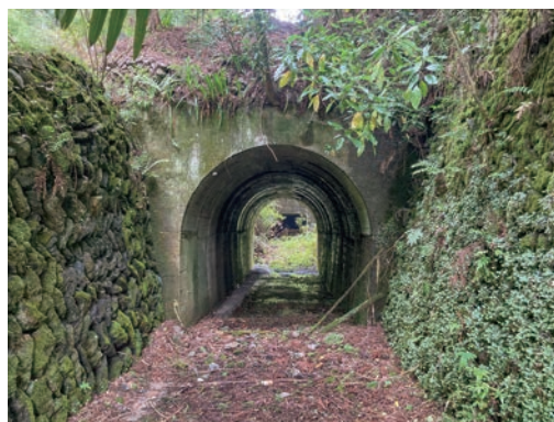
花坂隧道南西側入口
