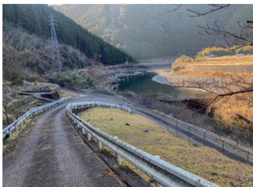
道になっている旧流筏路
