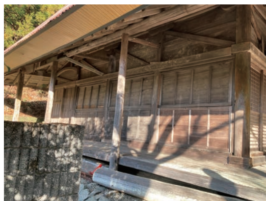
北寺観音堂西外壁
