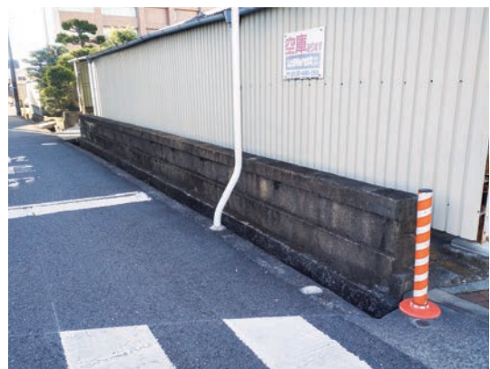
コンクリート製の塀
