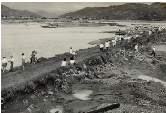
有田市保田水害被災状況 (和歌山県歴史資料アーカイブサイトより転載)
