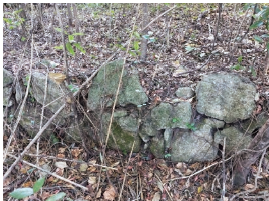
聴音壕設置平坦面を構成する石積み
