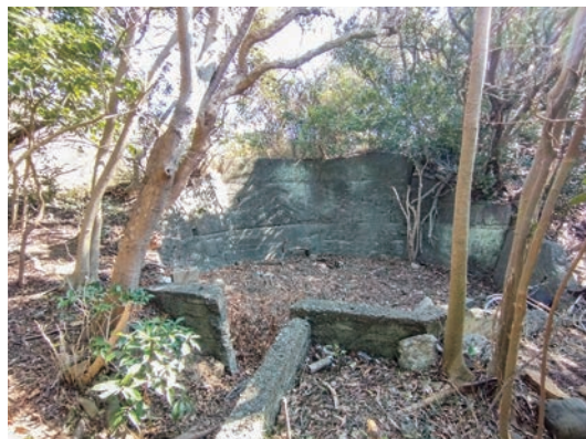
全景（西側より）
