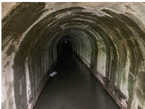
花坂隧道内部
