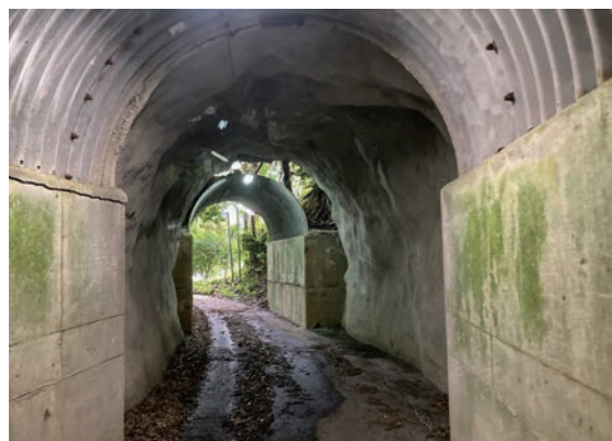
下古沢隧道内
