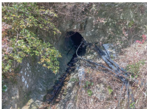
トンネル出口
