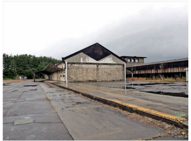
出荷倉庫とプラットフォーム
