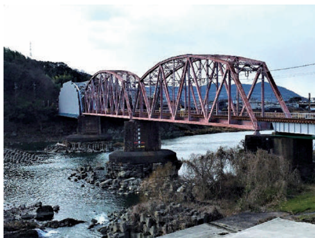
紀ノ川橋梁(岩出鉄橋) (岩出市提供、2023.2撮影)
