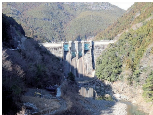
二川ダム (有田川町提供、2024.1 撮影)
