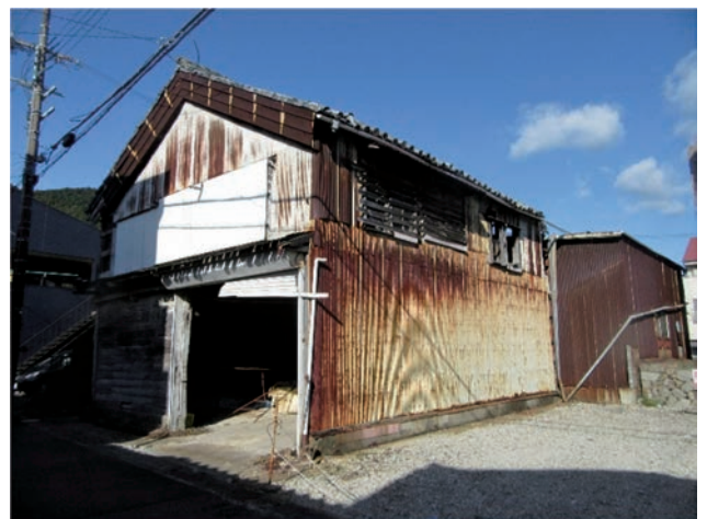
新宮製糸工場跡 繭の倉庫
