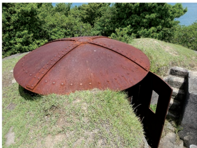
友ヶ島第1砲台 観測所 (和歌山県教育委員会、2022.7撮影)
