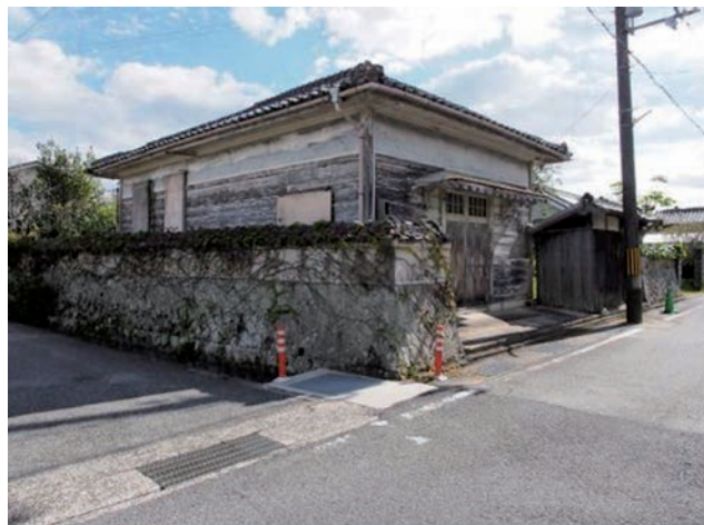
橋本家旧米穀集荷事務所
