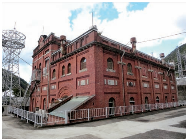
旧高津尾発電所 建屋 (日高川町提供、2021.11 撮影)
