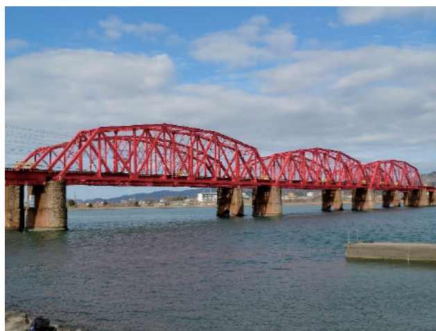
南海電気鉄道 紀ノ川橋梁 (和歌山県教育委員会、2024.2 撮影)
