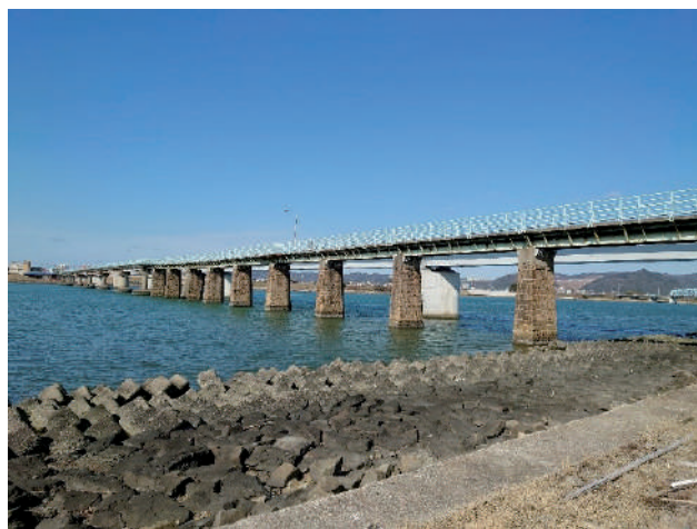
旧加太輕便鐵道 紀ノ川橋梁 (河西橋)
