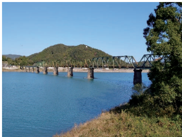
旧国鉄 熊野川鉄橋
