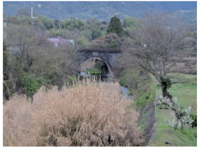
小田井灌漑用水路 龍之渡井 (かつらぎ町提供、2023.3 撮影)
