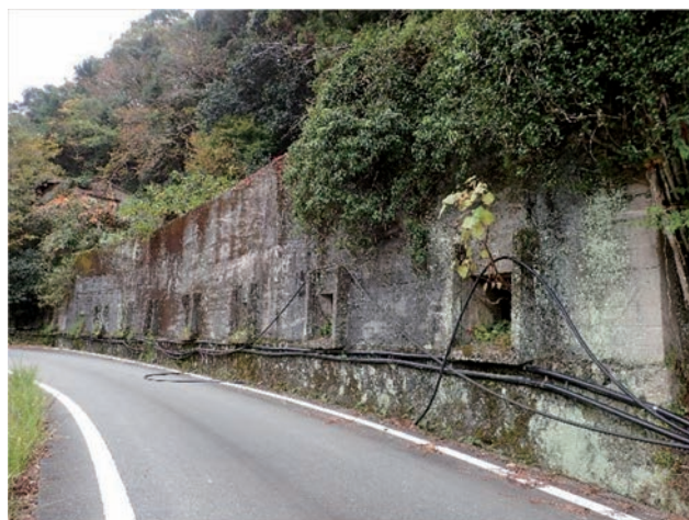
志古炭坑跡 ホッパー (新宮市提供、2019.12 撮影)
