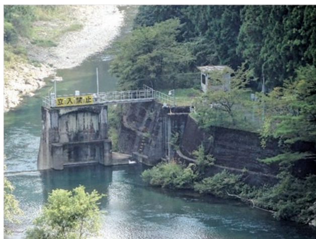
三田水力発電施設 堰堤 (和歌山県教育委員会、2022.10 撮影)
