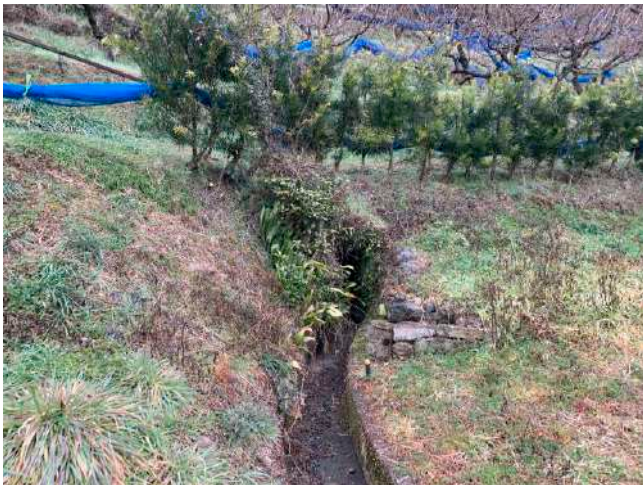
穂手見用水トンネル（島之瀬側から）
