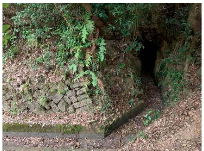
穂手見用水トンネル（東神野川側から）
