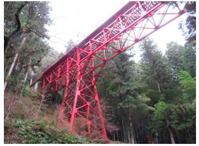
高野線中古沢橋梁
