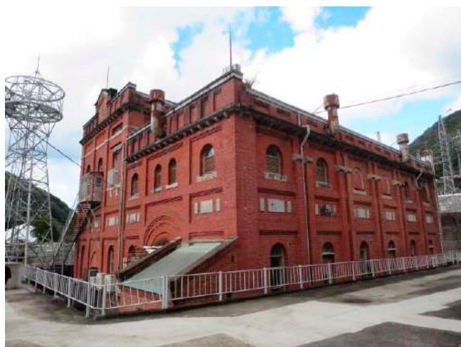
旧高津尾発電所 建屋全景
