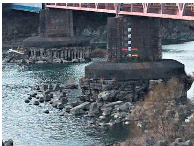
岩出鉄橋橋脚部
