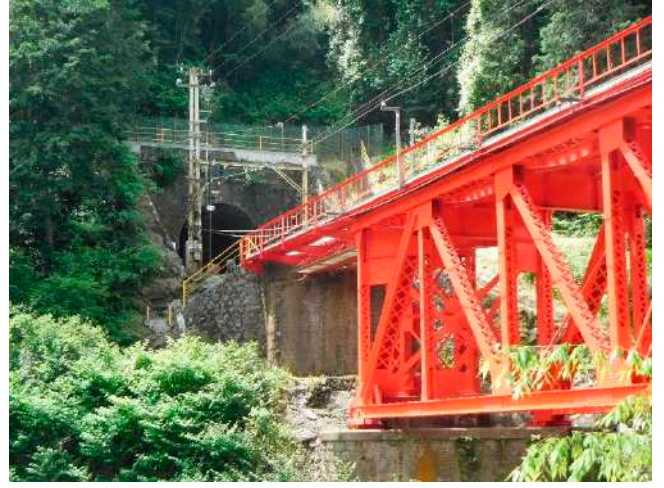
森林鉄道丹生川橋梁・隧道
