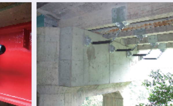
橋梁耐震化の施工例
