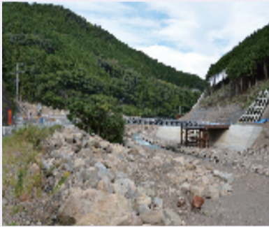
国道311号滝尻地区 復旧状況
