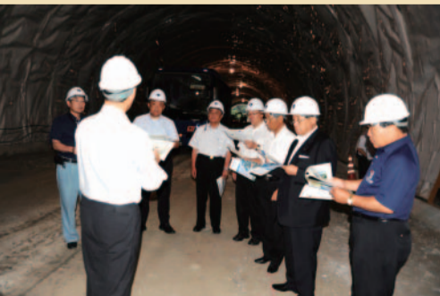
近畿自動車道紀勢線(田辺〜すさみ) 白浜町・平間トンネル工事現場
