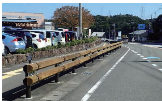
木製ガードレール(県道南紀白浜空港線)
