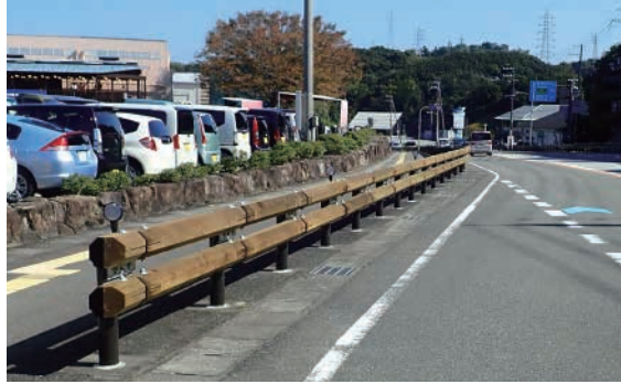
木製ガードレール（県道南紀白浜空港線）
