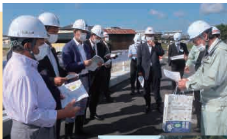
七瀬川改修工事
