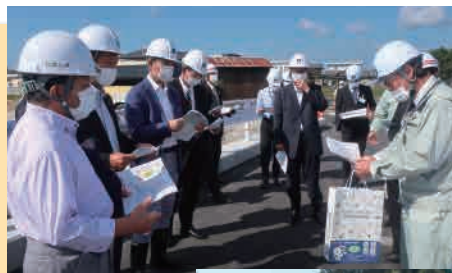
七瀬川改修工事
