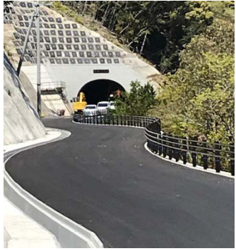
久木トンネル
