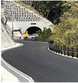
久木トンネル
