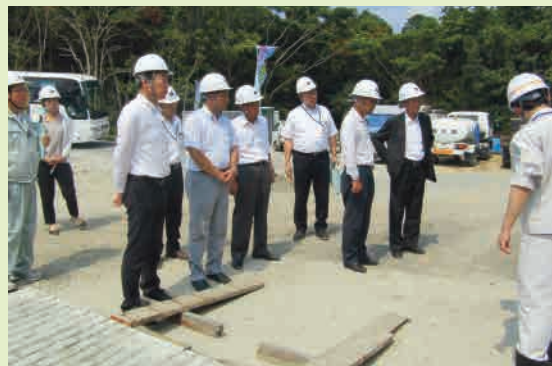
すさみ申本道路における調査の様子
