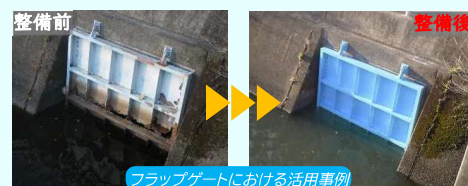
フラップゲートにおける活用事例
