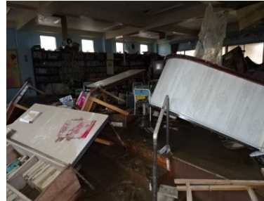
令和2年7月豪雨の被害
