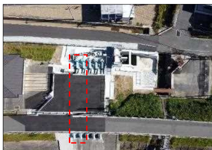
排水ポンプ増設
