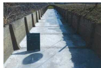
底張コンクリート
