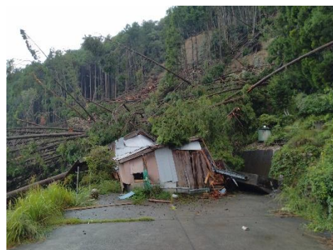
【家屋被災状況】
