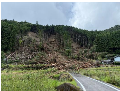
【末端部被災状況】
