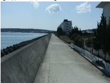
【堤防の嵩上げ】
