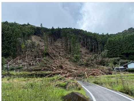
【末端部被災状況】
