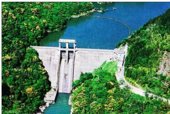
七川ダム〔昭和31年3月竣工〕
