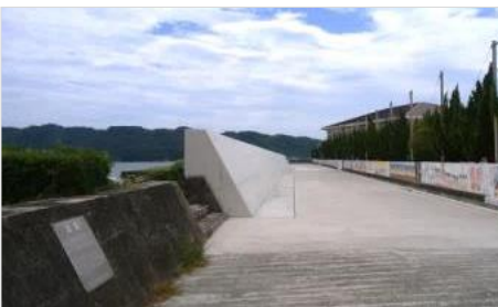
【堤防の嵩上げ】
