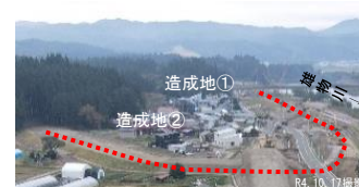
移転家屋の建設が進む状況
