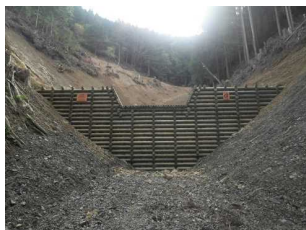
溪間工事の例
