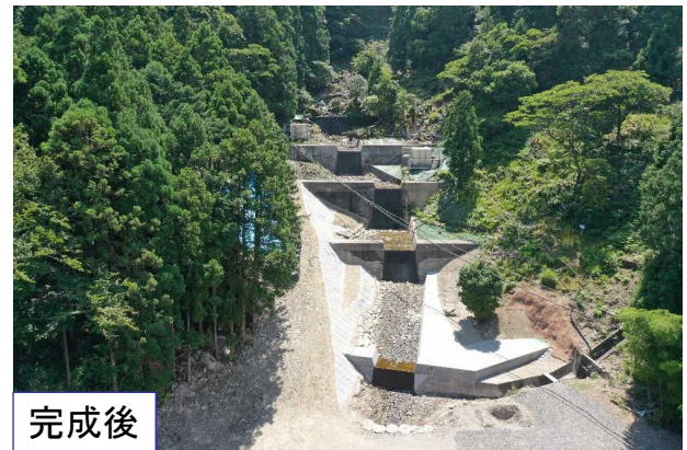
溪間工により復旧
