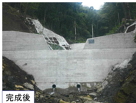
溪間工により復旧
