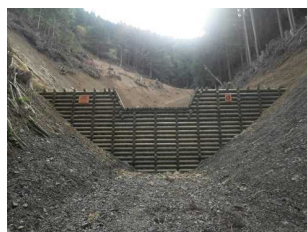
溪間工事の例
