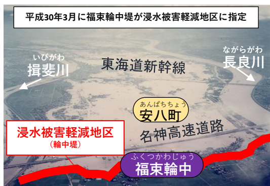
福束輪中堤(昭和51年9月 台風17号浸水時)
