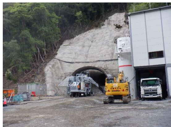
▲ 庄川～久木工区（仮称庄川久木1号トンネル）
