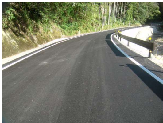
▲ 石船～向山工区（大内川地内）
