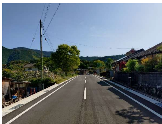
▲ 東～殿原工区（東地内）
