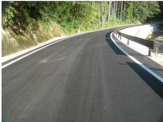
▲ 石船～向山工区（大内川地内）
