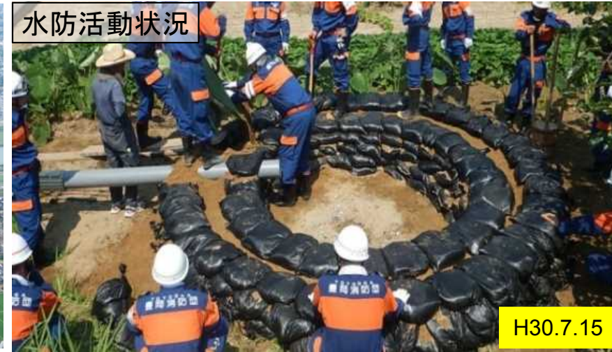
釜段工完了
