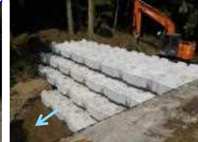
ブロック堰堤<7/17設置>
