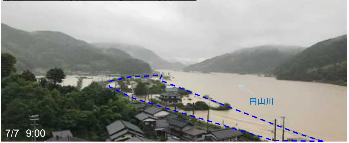
平成30年7月豪雨による下流部の浸水状況
