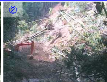
倒木・流木撤去および進入路設置状況<7/25時点> (webカメラより)
