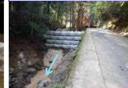
ブロック堰堤<7/15設置>
