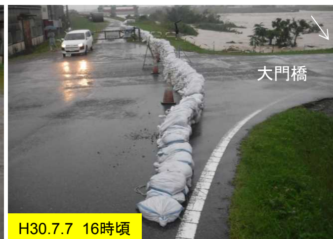
積み土のう工完了
