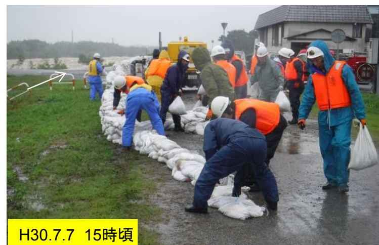
積み土のう工実施状況
