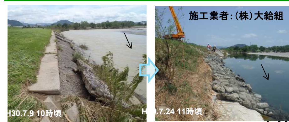
護岸損傷<揖保川右岸10.2k(たつの市)>
