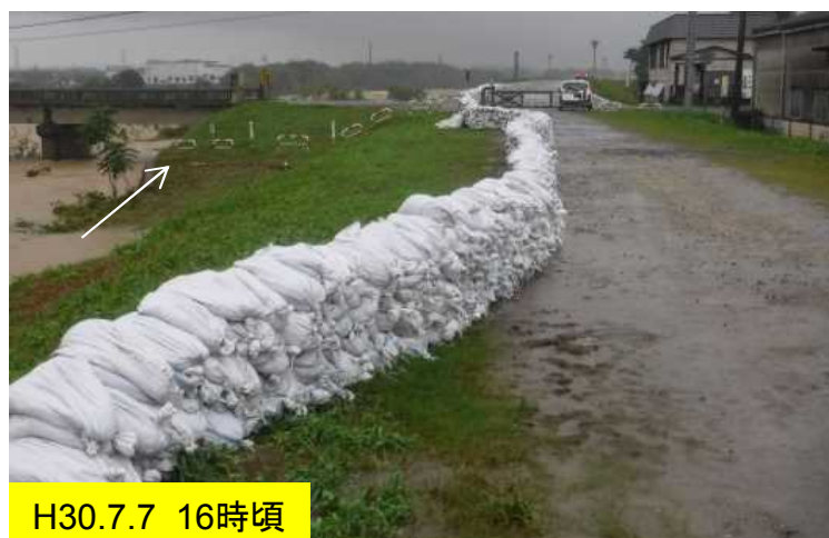
積み土のう工完了
