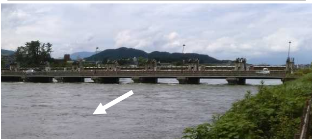
瀬田川洗堰全開放流状況 (7月8日13時頃)
