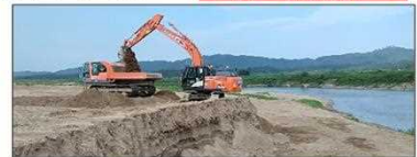
河道掘削・積込(場内運搬)の状況 (R4.8.23 撮影)
