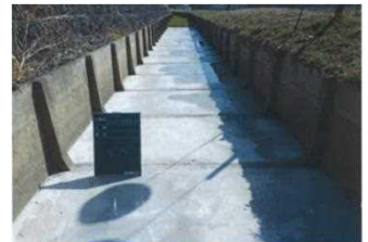
底張りコンクリート
