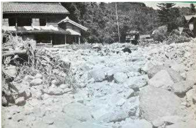
「羽越水害」の被害写真
