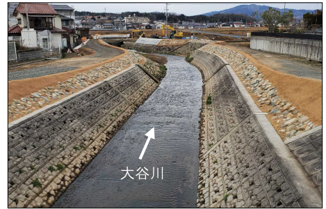
広島県による支川の改修
