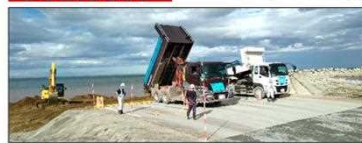
養浜材の荷下・投入状況 (R4.8.18 撮影)
