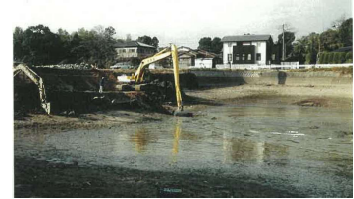
＜ため池の浚渫工事＞
