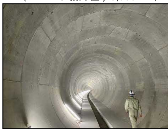
雨水貯留管内部 (仕上がり内径φ5,250mm)
