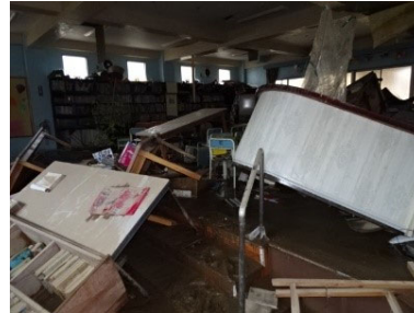
令和2年7月豪雨の被害
