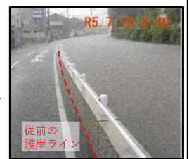
<池町川護岸高上げ>
