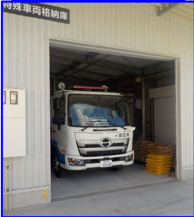
排水ポンプ車保管場所
