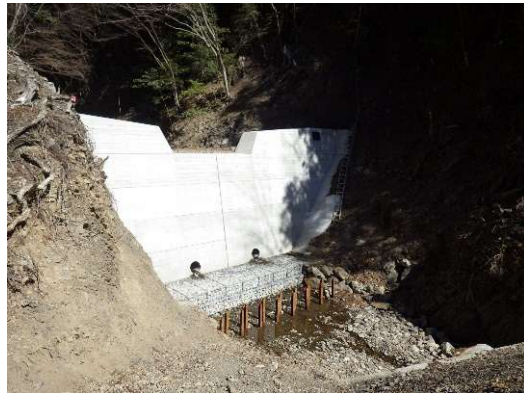
溪間工事（坂泰山国有林）
