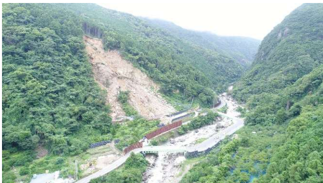
民有林直轄治山事業 (上秋津区域における斜面の崩落状況)
