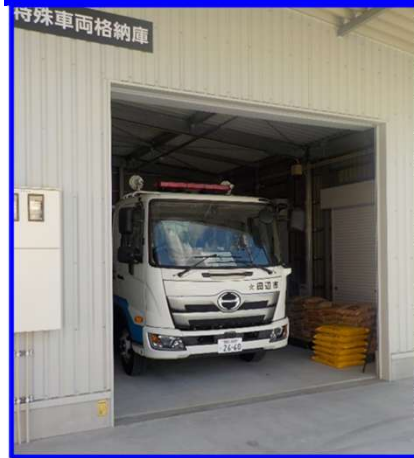
排水ポンプ車保管場所
