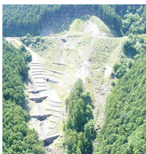
紀伊田辺地区民有林直轄治山事業における山腹工及び谷止工（田辺市 本田垣内区域）
