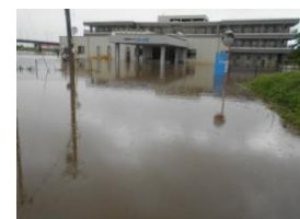
浸水時の状況 (喜多方市提供)
