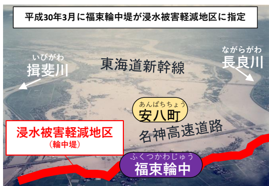
福東輪中堤(昭和51年9月 台風17号浸水時)
