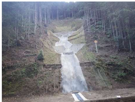
山腹工事（川又国有林）
