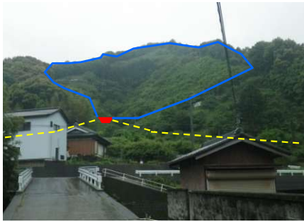
砂防堰堤の新設
