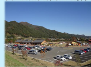
交流施設の整備 (ハツ場ダム)
