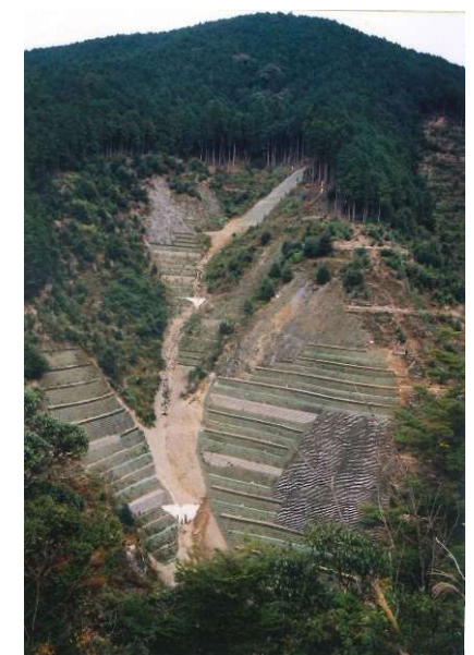
山腹工事の施工状況
