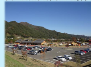
交流施設の整備 (ハツ場ダム)
