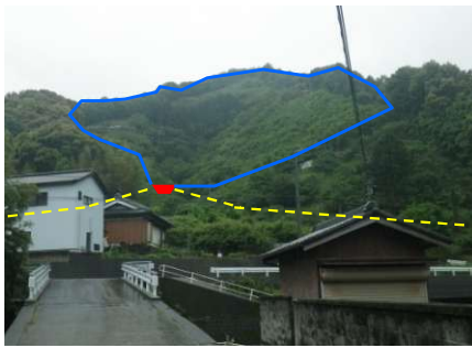
砂防堰堤の新設
