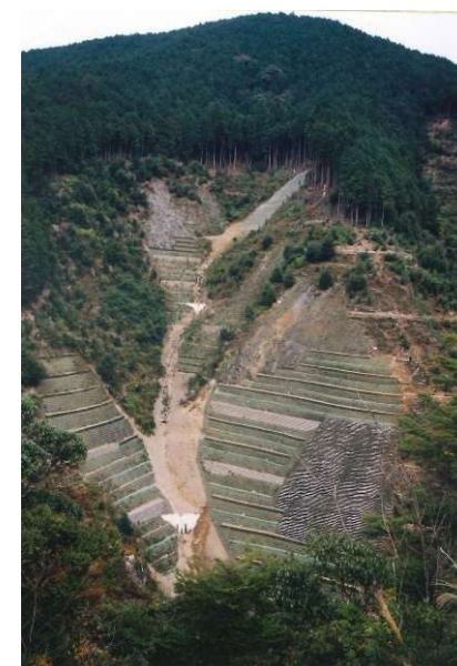
山腹工事の施工状況
