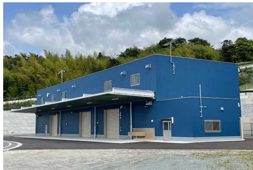
みなべ町防災備蓄倉庫完成(R5. 4月)
