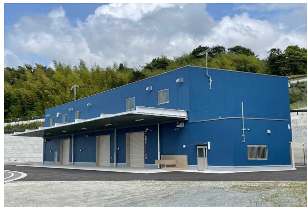
みなべ町防災備蓄倉庫完成(R5. 4月)
