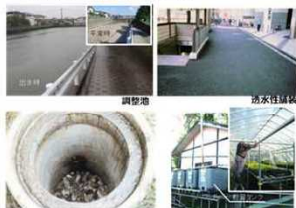
雨水貯留浸透施設の例
