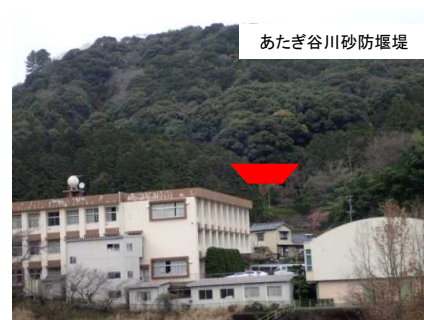
砂防堰堤の新設
