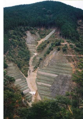
山腹工事の施工状況
