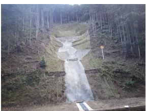
山腹工事（川又国有林）
