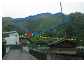
砂防堰堤の新設
