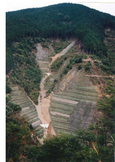
山腹工事の施工状況
