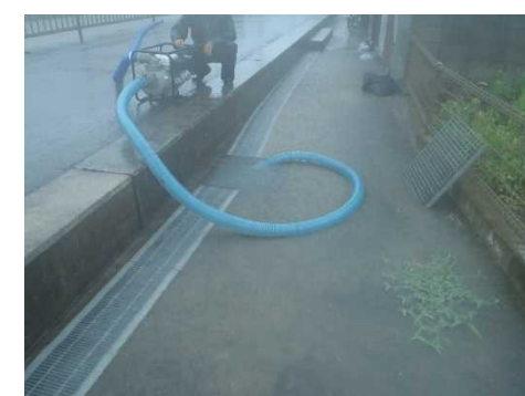
稼働時況(出水時)
