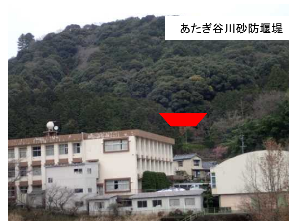
砂防堰堤の新設
