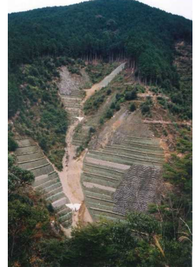
山腹工事の施工状況
