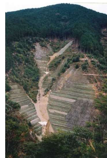
山腹工事の施工状況
