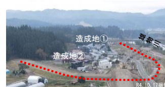
移転家屋の建設が進む状況
