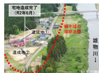
移転先宅地完成完了状況
