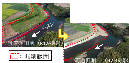
河道掘削(鹿児島県山川内川水系羽月川)
