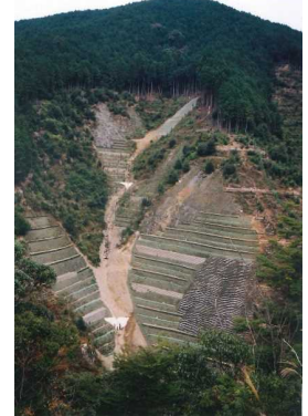
山腹工事の施工状況
