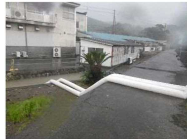
島田地区 水路での排水状況
