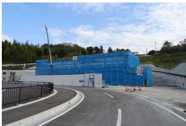
防災備蓄倉庫建設中
