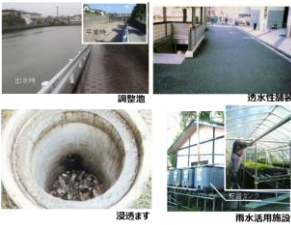
雨水貯留浸透施設の例
