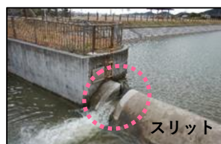
▲スリットの設置状況
