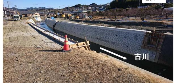
○南部川流域である方丈谷川において砂防堰堤工を実施し、下流にある人家等を土石流から保全する。
