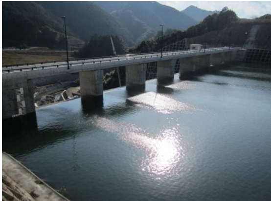
ダム上流左岸側からの様子
