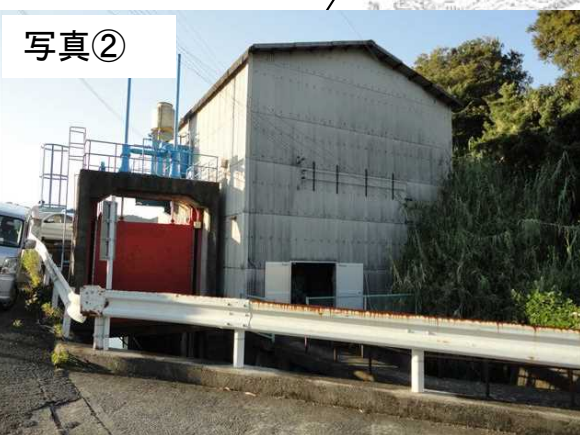
※栖原ポンプ場
