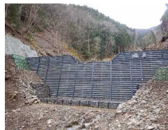
国有林直轄治山事業における谷止工 (有田川町 津俣国有林)
