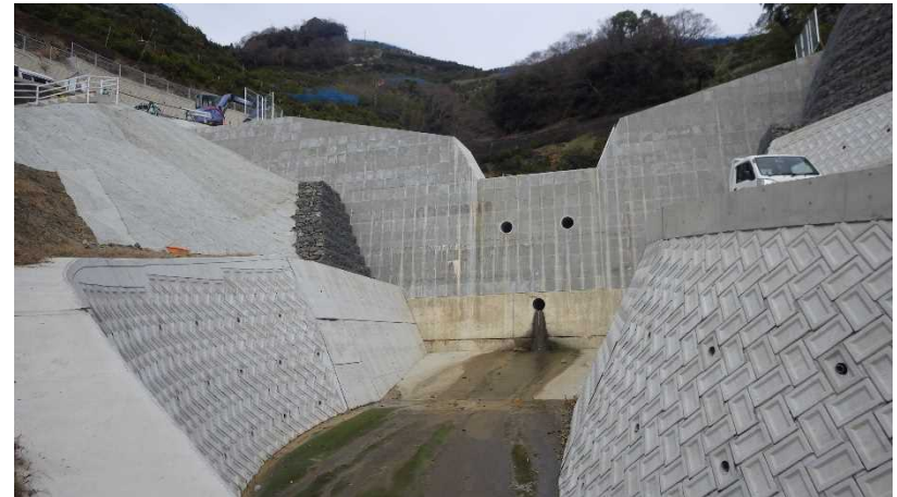
砂防堰堤の新設
