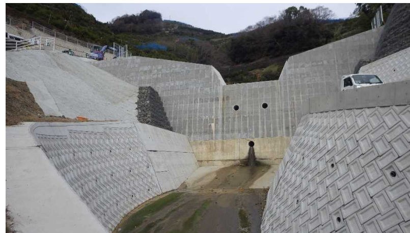
砂防堰堤の新設
