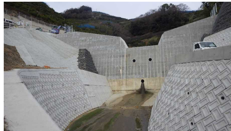
砂防堰堤の新設
