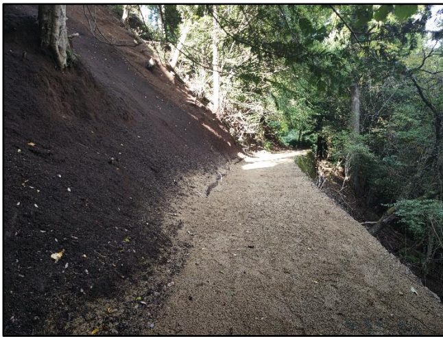
町石道復旧完了状況
