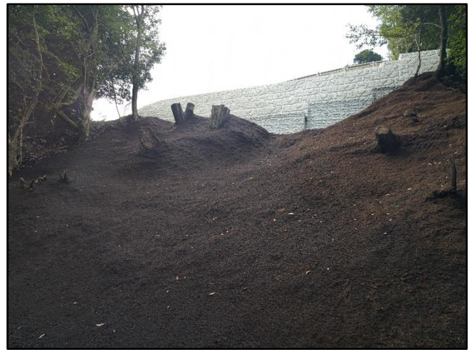
擁壁下部斜面復旧完了状況
