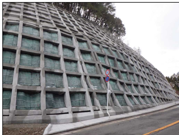
法面補強工事
