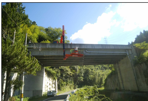
橋梁点検（橋梁点検車）
