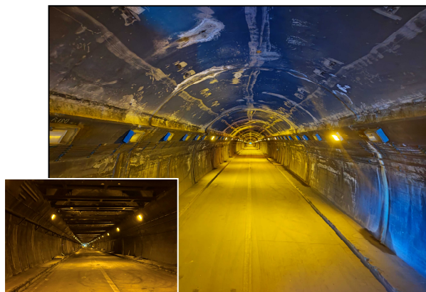
トンネル補修工事（天井板撤去）
