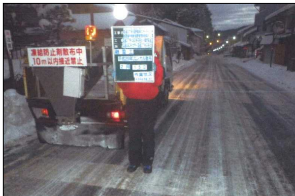
【凍結防止剤（塩化カルシウム）の散布状況】
