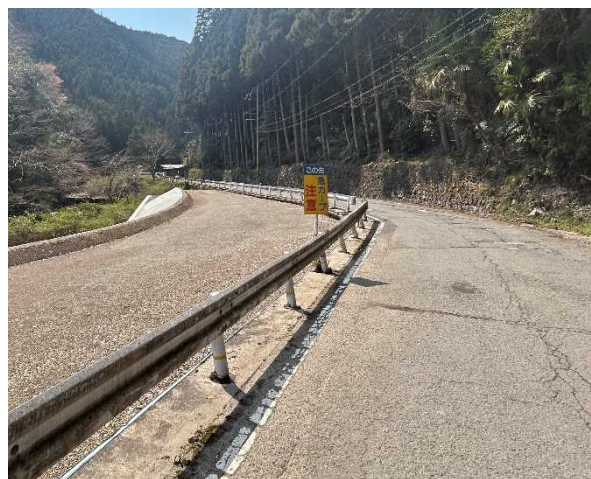
県道花園美里線（１工区）工事中
