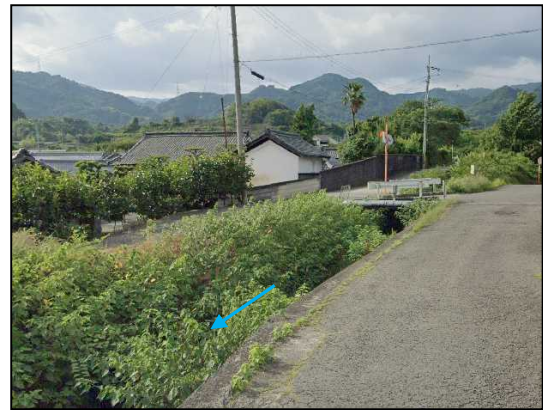
【未整備区間(0.65k 付近)】
