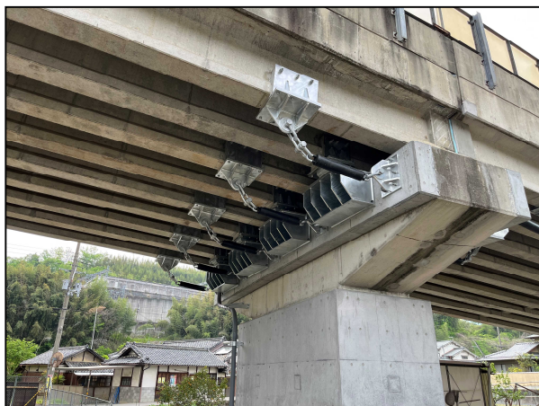
橋梁耐震補強工事
