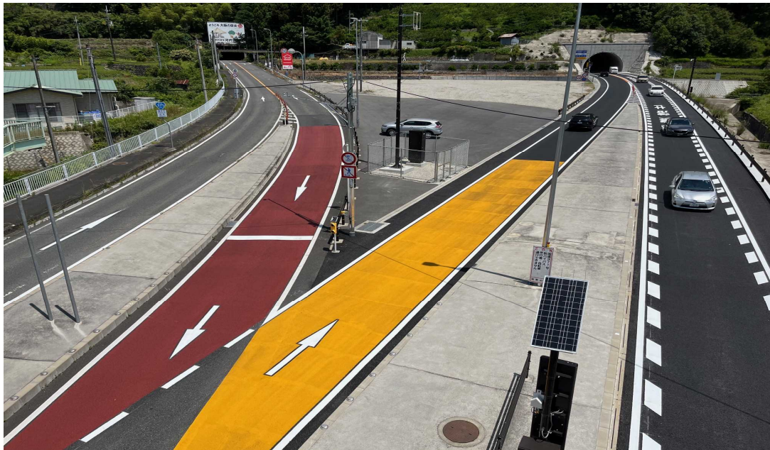
【国道 3 7 1 号道路改良工事（橋本市 柱本 令和 6 年 6 月完成）】
