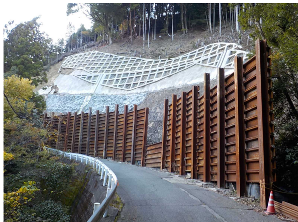
【国道３７１号（林工区）工事中】
