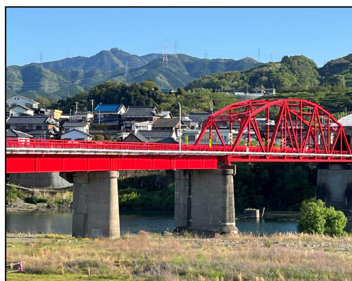
橋梁補修工事（塗装塗替）
