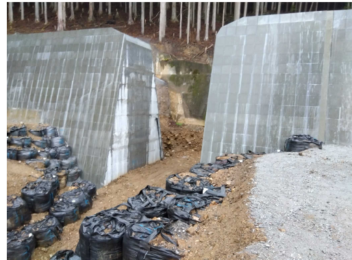
【砂防えん堤整備状況】
