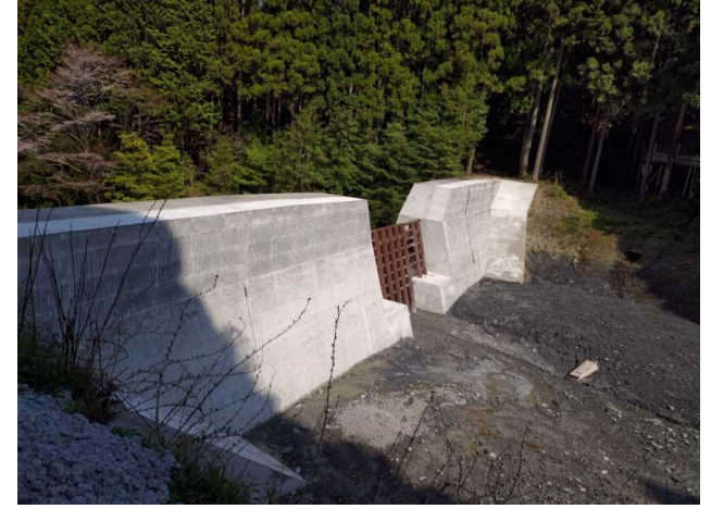
堰堤改築後(椿谷川)
