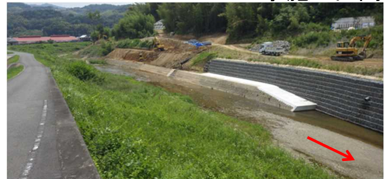
工事施工区間
