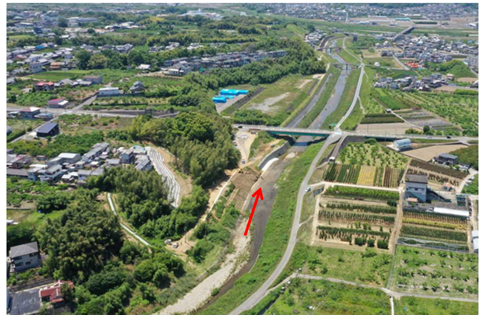
工事施工区間
