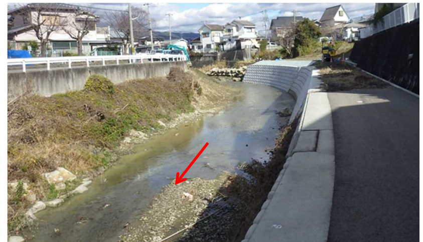
工事施工区間
