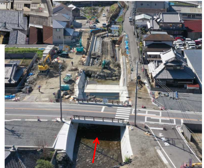
工事施工区間
