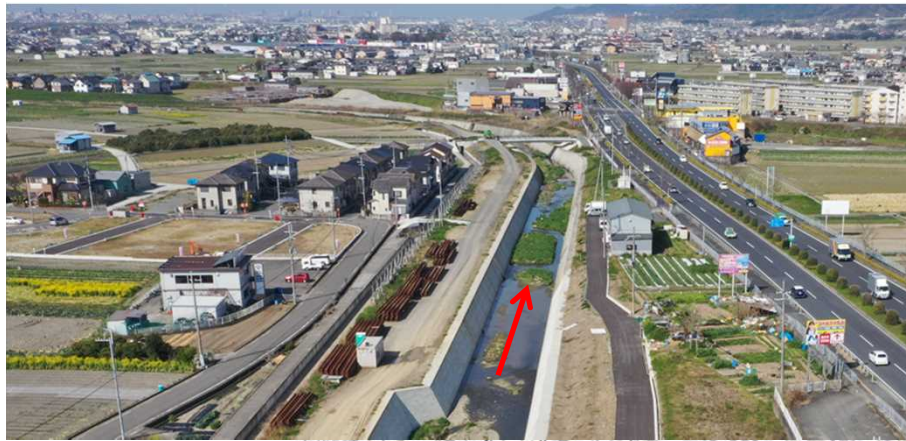
工事完了区間
