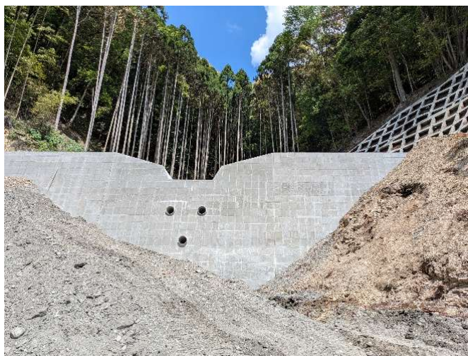
垣内川砂防事業（紀の川市桃山町垣内）
