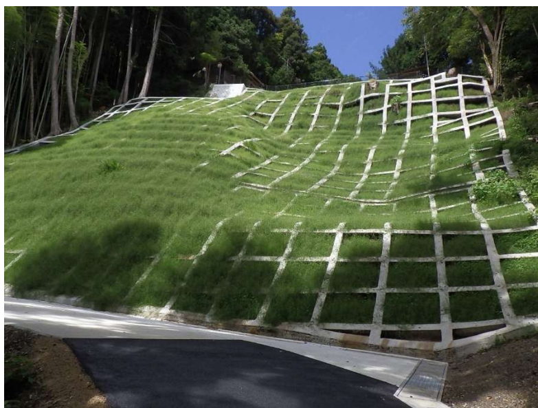
寺垣内5地区急傾斜地崩壊対策事業（紀の川市桃山町黒川）
