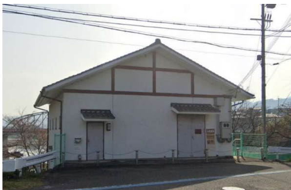
九度山ポンプ場（九度山町入郷）
